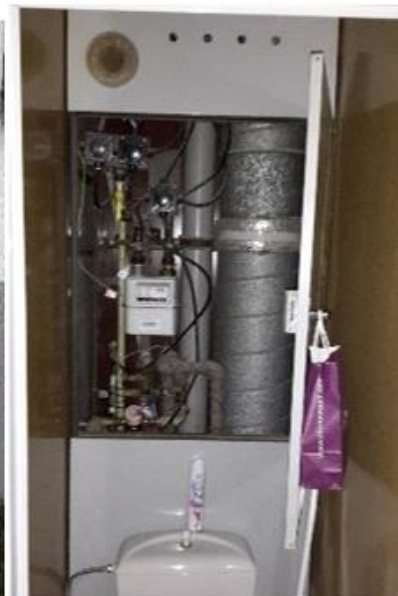
v bytovém jádře
