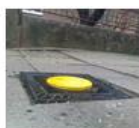
Obr. 20 - Příklady umístění HUP/uzávěrů na OPZ
